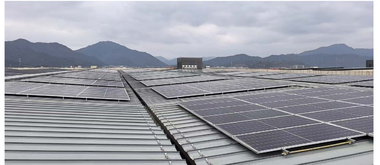
象山物流倉庫佈設光伏發電
